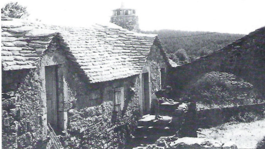
3 La Volpilière : Maison au toit restauré, dans la rue de l'Arc.
